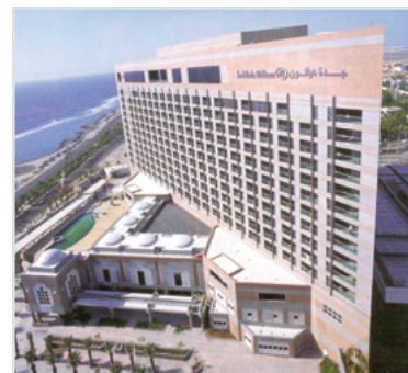
Hilton Hotel, Jeddah
